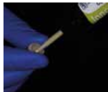
17. Application de la colle dans l'intrados
